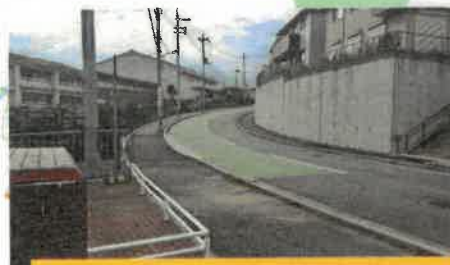
① 小学校車両出入口 (防火水そう前)
